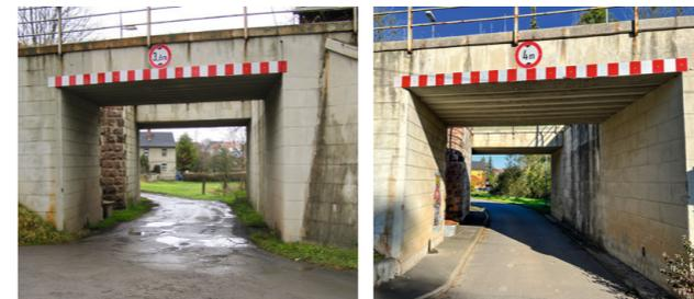
Sanierung und Erhöhung der Durchfahrt der Bahnunterführung vor Instandsetzung (links) und nach Instandsetzung (rechts)
